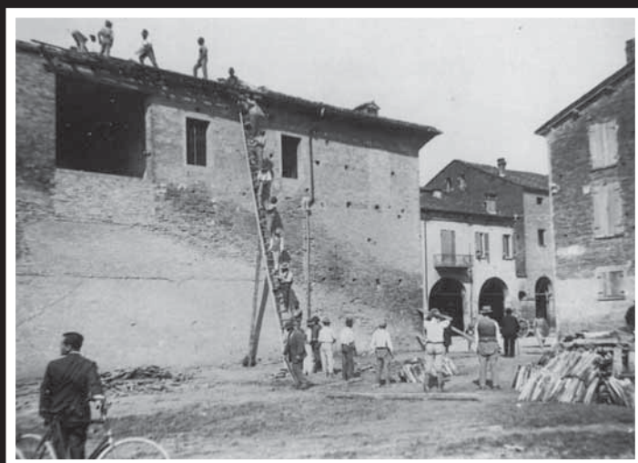
Passamano di tegole durante il rifacimento del tetto di una casa a Carpi, 1930 ca.
