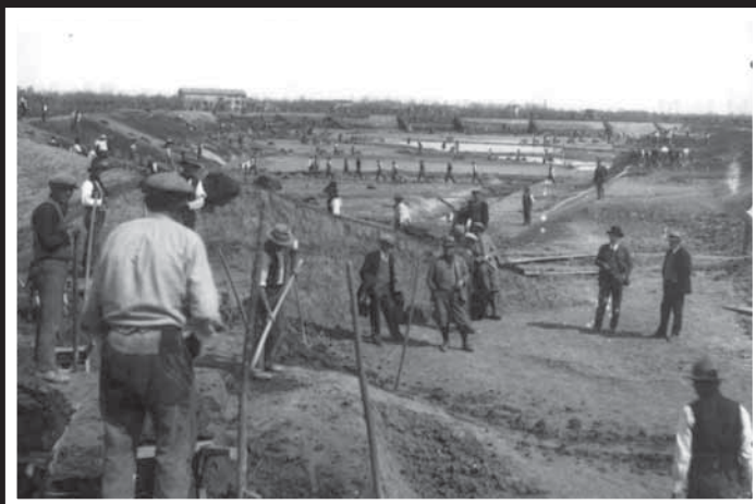
Lavori di sistemazione della Fossa Raso presso Novi di Modena, 1931
