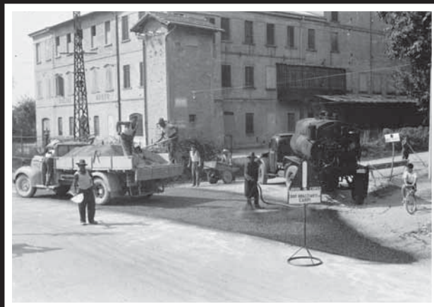
Bitumatura di Via San Giacomo a Carpi, 1955 Carpi, Archivio storico Cmb
