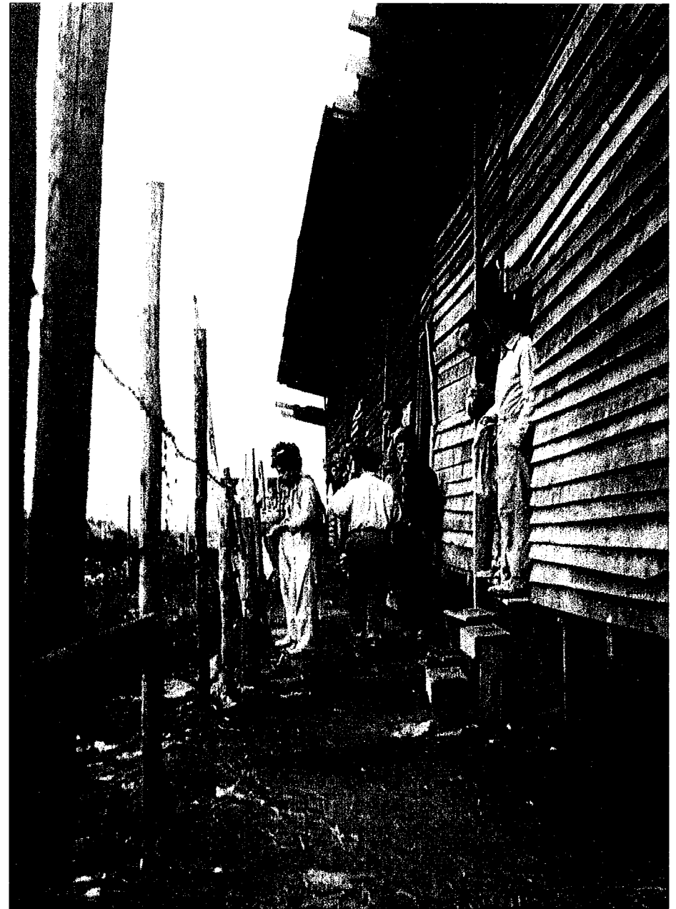
Operai edili milanesi pernottano nelle baracche del cantiere messe a disposizione dal costruttore, Milano, s.d.
